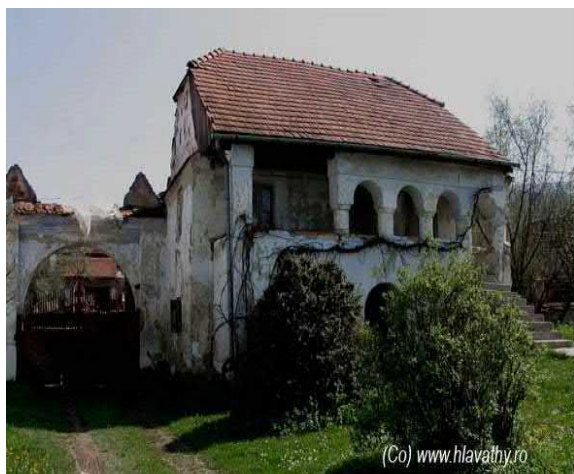
înainte de renovare
